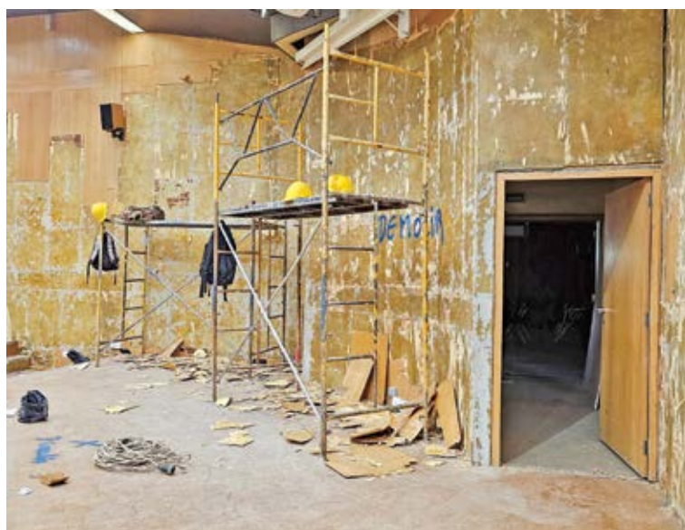
O auditório da ESE já se encontra em obras
